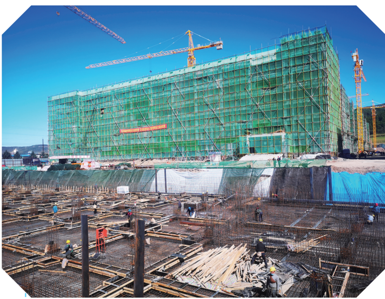
汪清绿电科技园建设项目总投资5.78亿元,占地面积约9.3万平方米,总建筑面积约14.69万平方米,主要建设标准化厂房8栋、宿舍楼4栋及动力中心,同时建设相关配套附属设施、绿化景观、道路等,项目拟在建筑物楼顶和周边空地安装光伏板进行发电,供给入园企业使用清洁能源。该项目建成后,可为20家左右企业提供创业服务。 张卫国 摄
