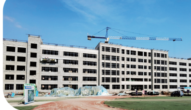
柳河县长青小学异地新建项目正加紧建设。 本报记者 隋二龙 摄
