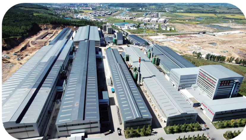
鸟瞰中溢集团(吉林)新能源科技有限公司项目。杨得茗 摄
