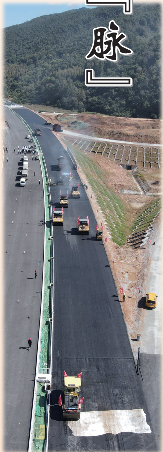
恒集高速公路项目施工现场。
