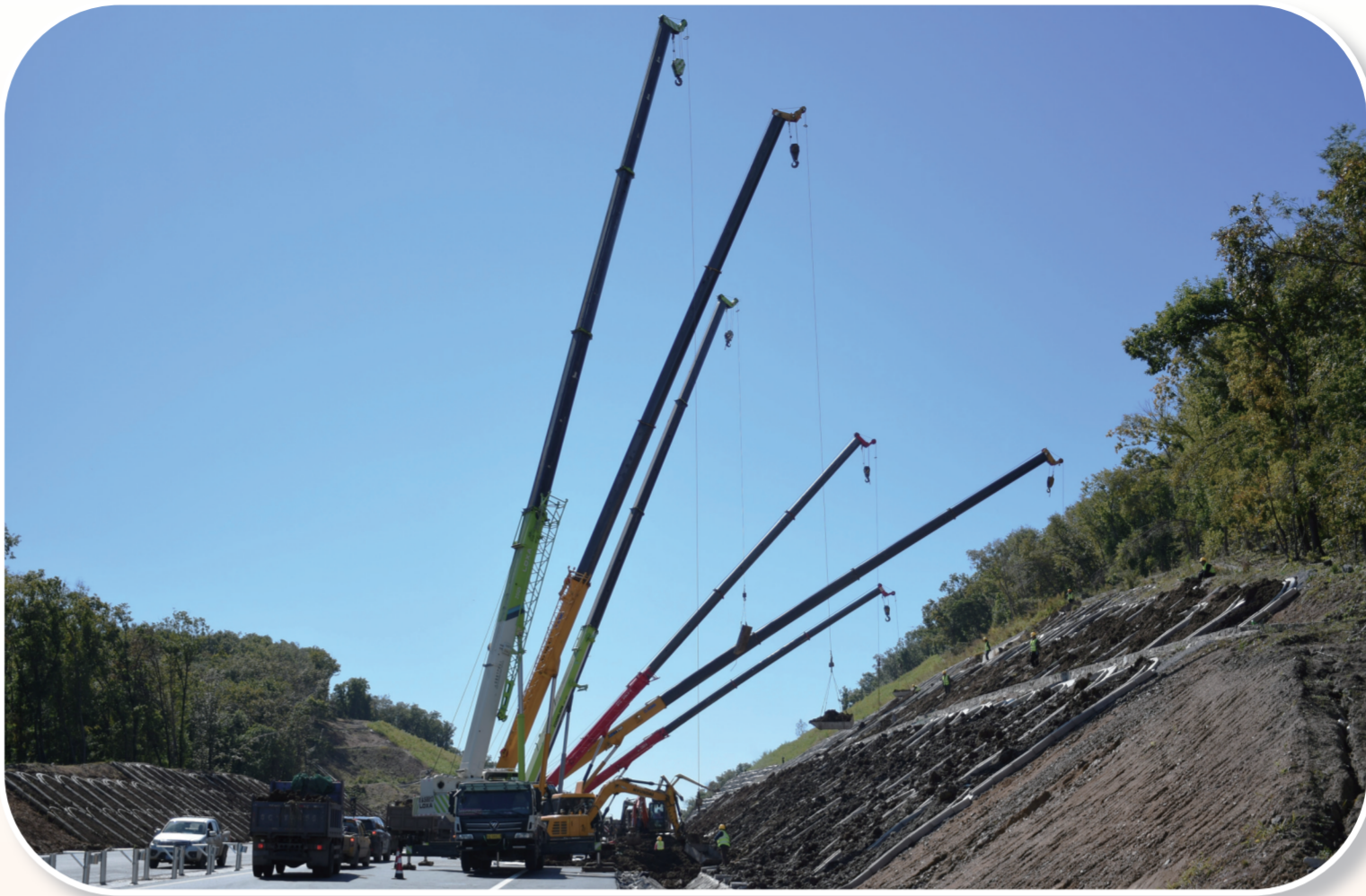
长春经济圈环线高速公路边坡填土工作施工现场。
