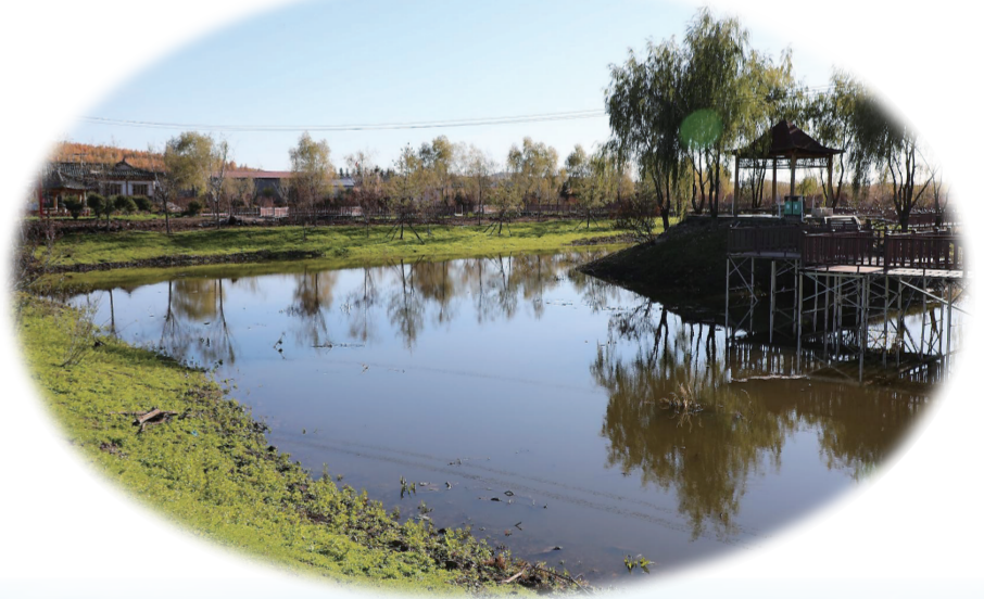
▲敦化市“水系连通”一期绿水长廊项目
