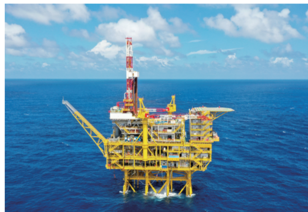
这是深水导管架平台“海基一号”(无人机照片,9月30日摄)。
