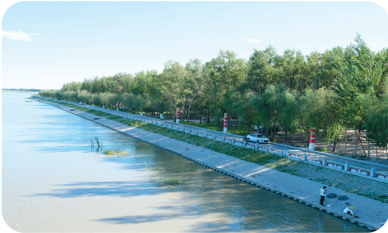
我省首批万里绿水长廊建设试点项目，西辽河一期绿水长廊项目城区段。
