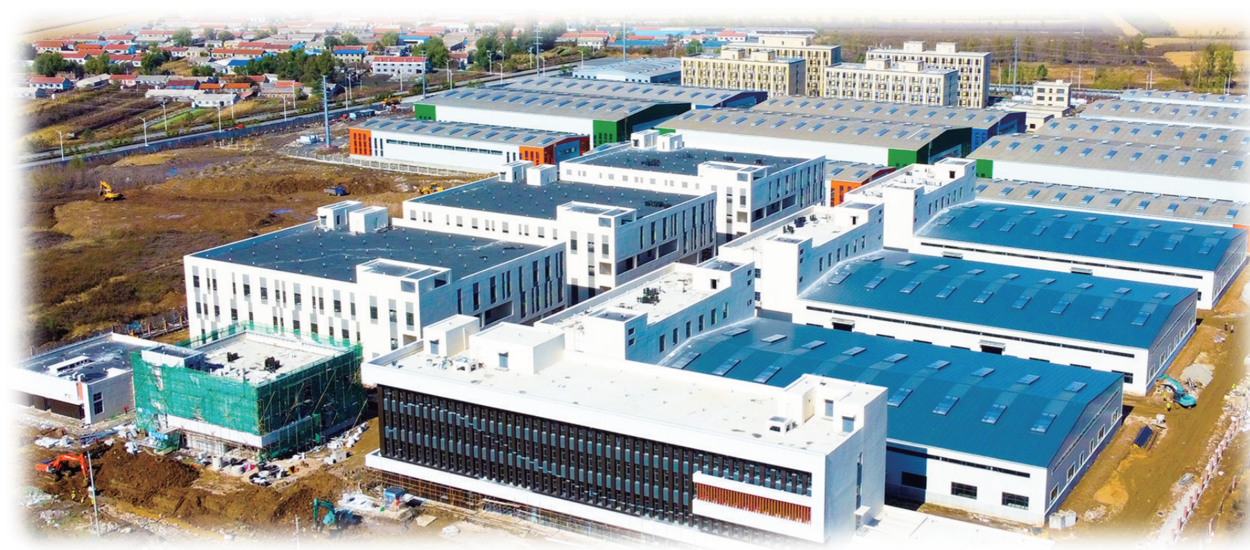
长春二道经济开发区智能家居产业园区项目正在建设中。
