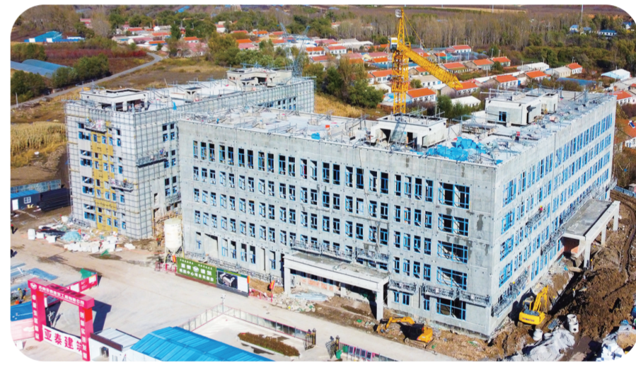
长春市二道区疾病预防控制中心项目正在建设中。
