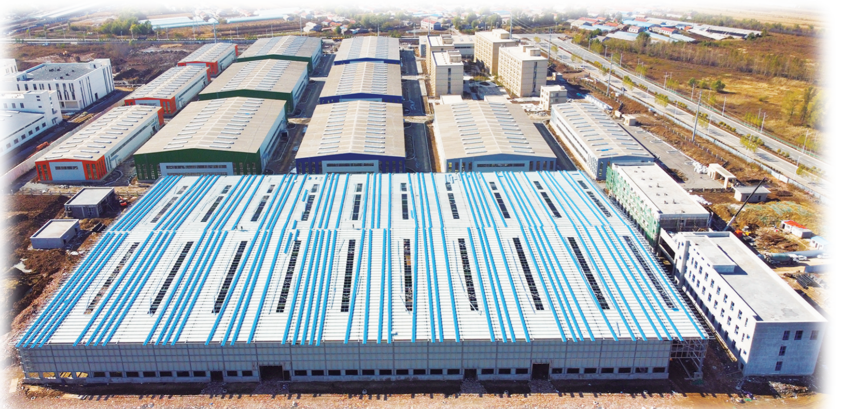
长春中拓塑业科技有限公司汽车零部件数字化工厂及研发中心项目正在建设中。
