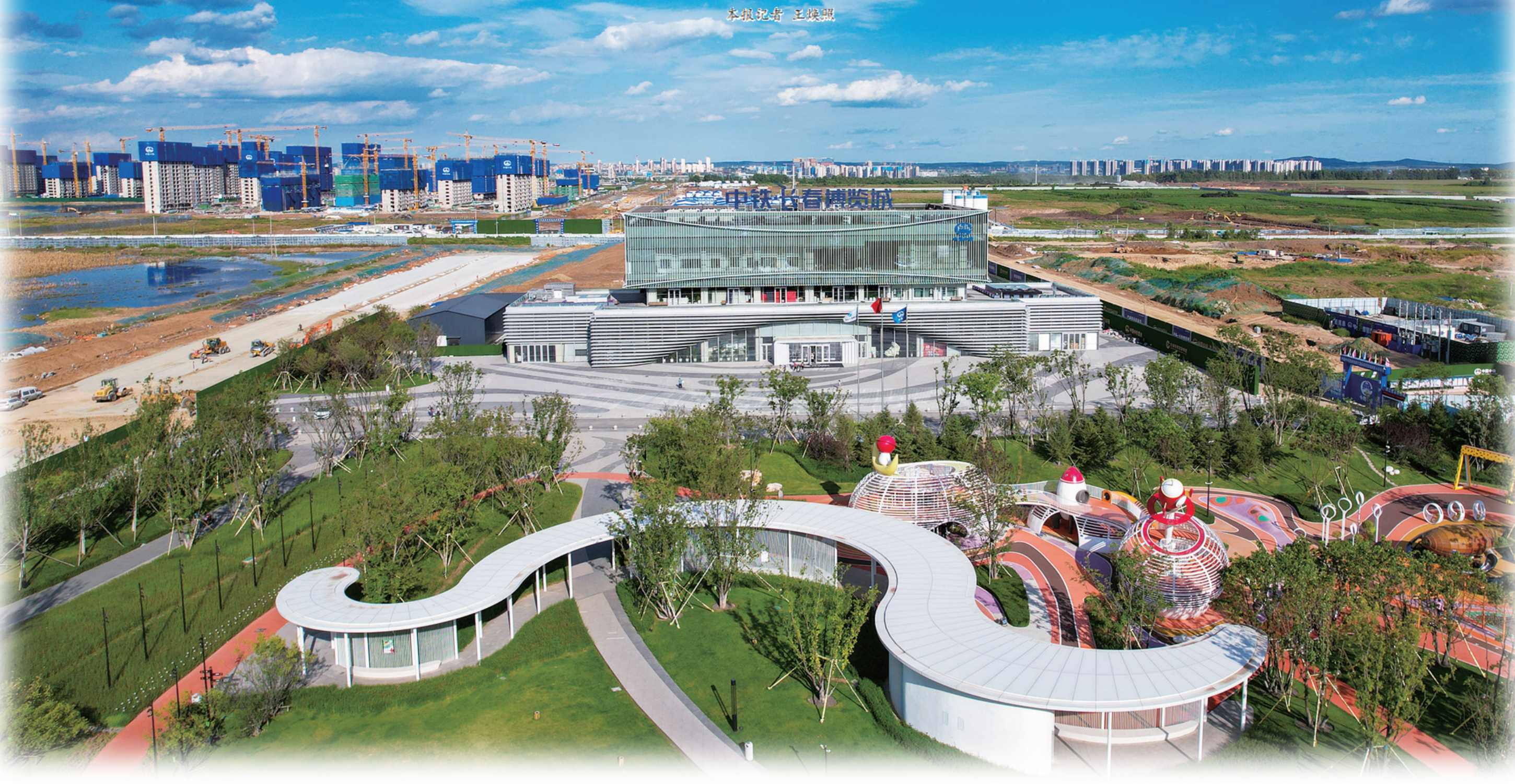
长春市朝阳区永春新区中铁·长春博览城项目。
