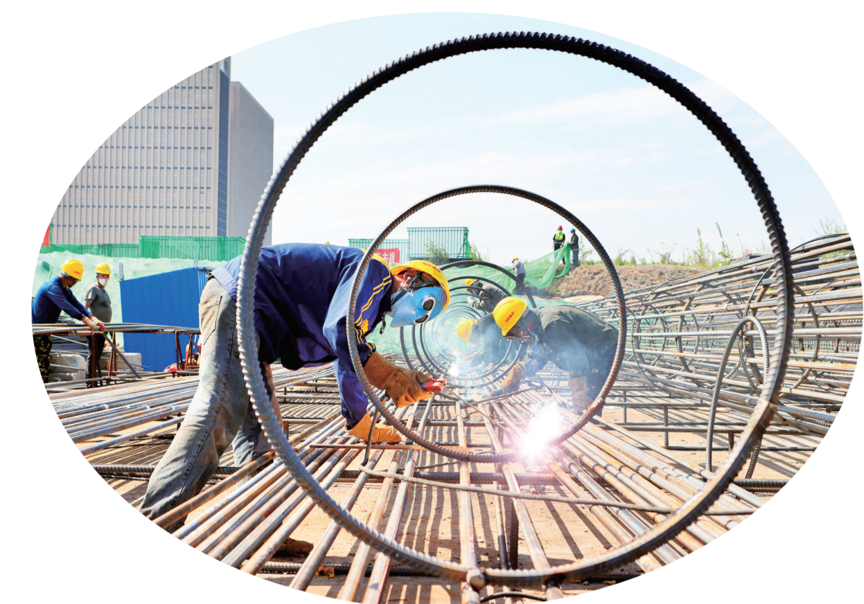
火热的地铁施工现场。
