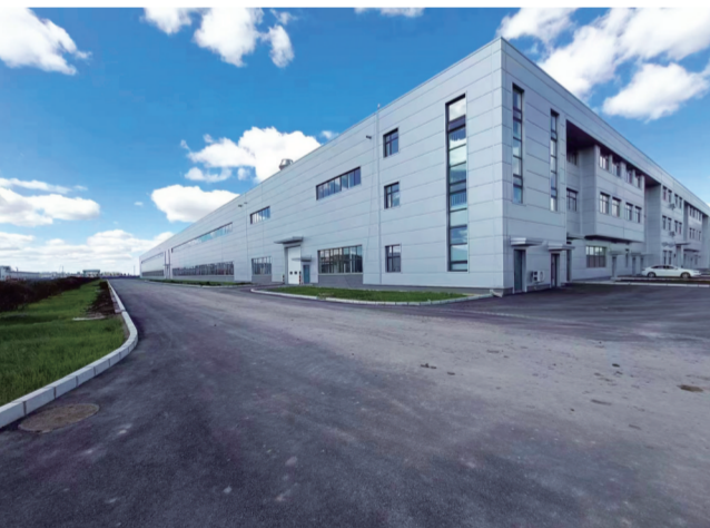
长春中车轨道车辆有限公司整体搬迁建设项目。
