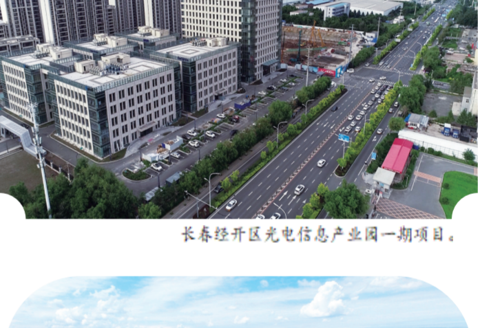
长春经开区光电信息产业园一期项目。
