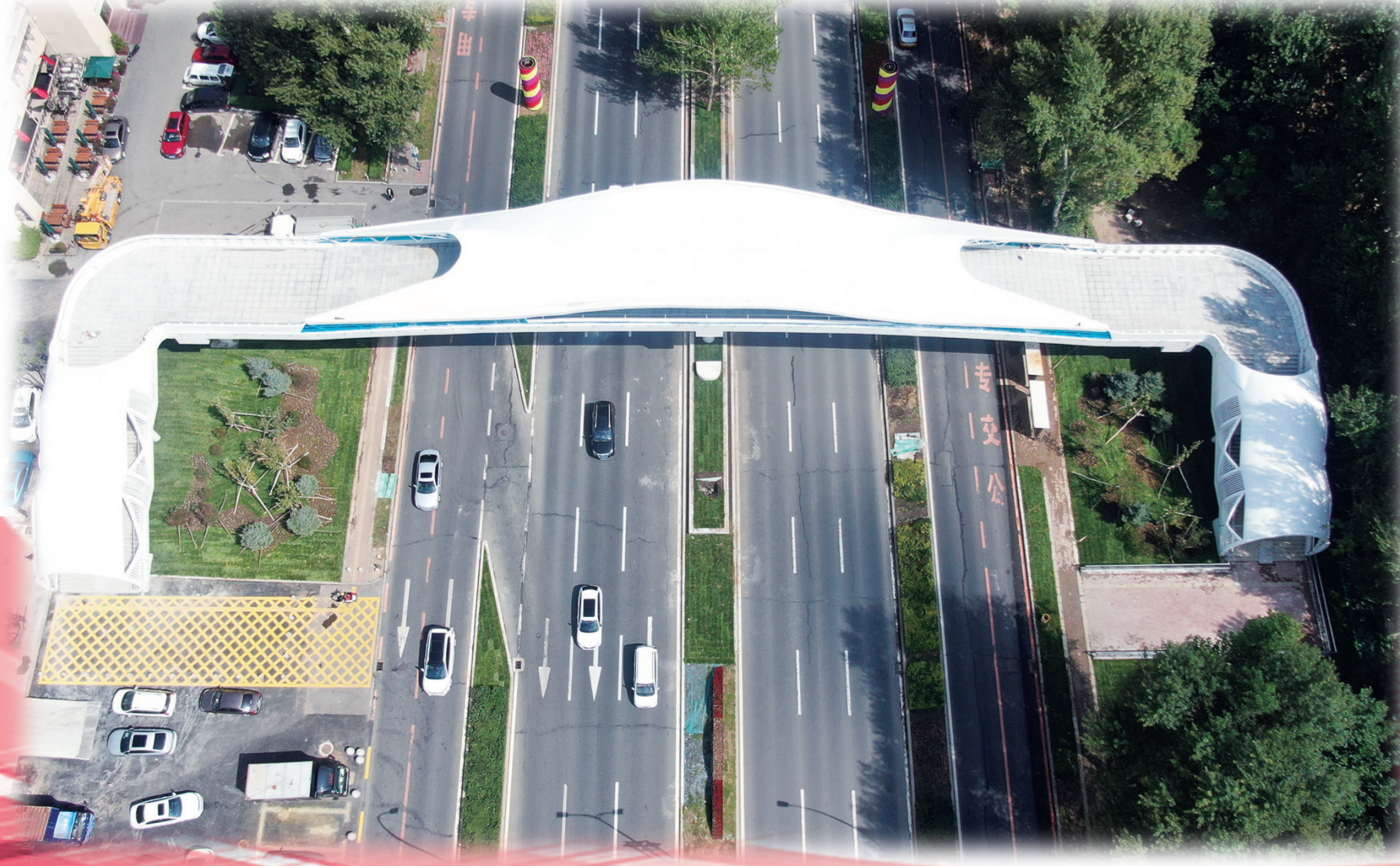
飞跃路天桥9月1日投入使用。
