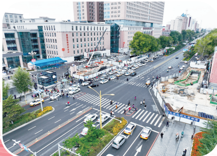
正在建设中的吉大一院地下过街通道。
