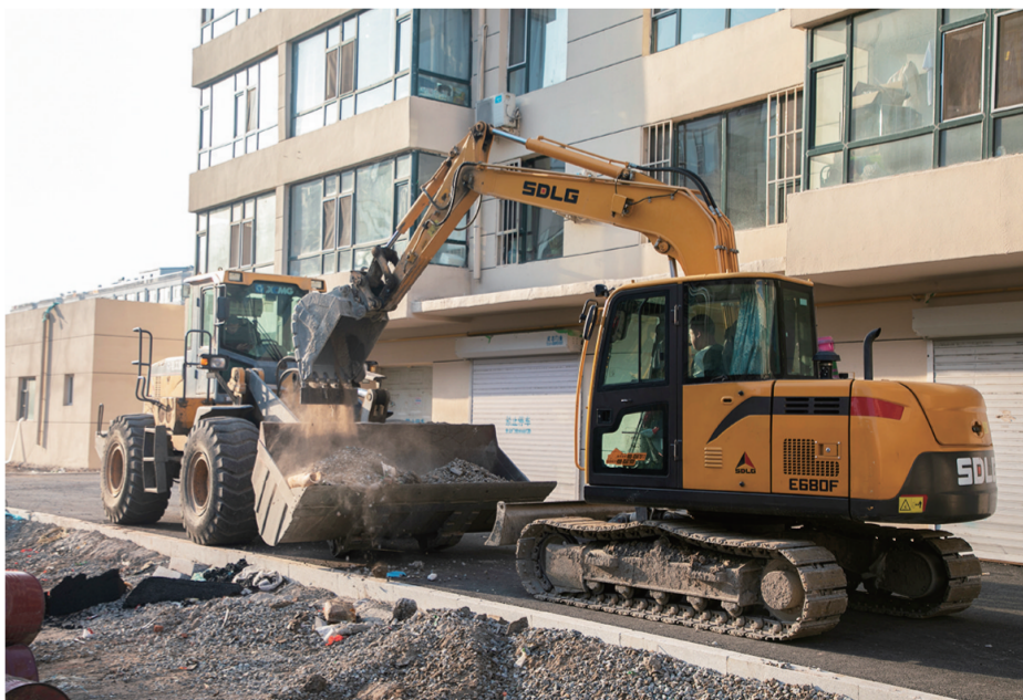
随着冬日临近,松原市今年开工的海绵城市建设项目都在抢抓最后的施工期,确保项目早完工、早惠民。
