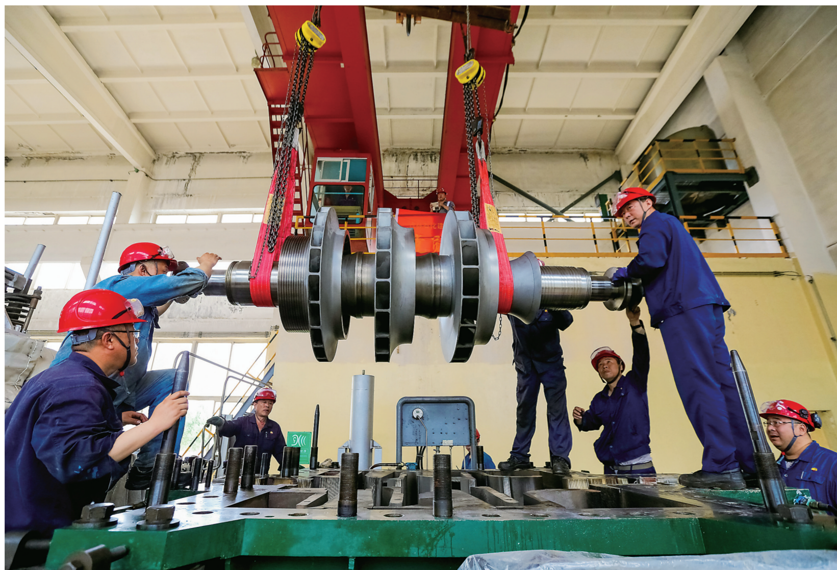
连日来,吉林石化丙烯腈厂积极开展隐患排查工作,对重要设施以及各易泄漏、易冲蚀部位逐一梳理,确保隐患排查、立查立改,为冬季安全生产打好基础。图为工人正在进行设备检修。本报记者 王萌 摄
