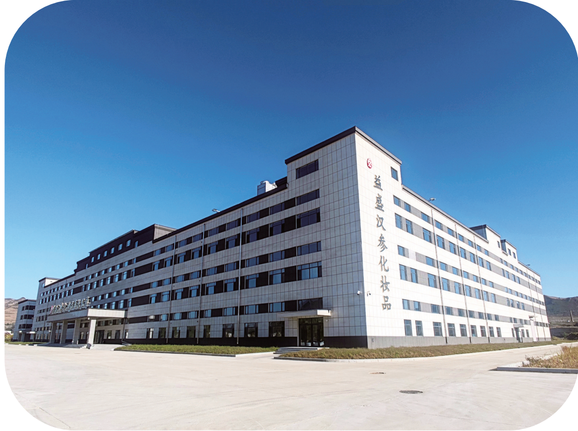
集安益盛汉参化妆品有限公司车间生产楼。
