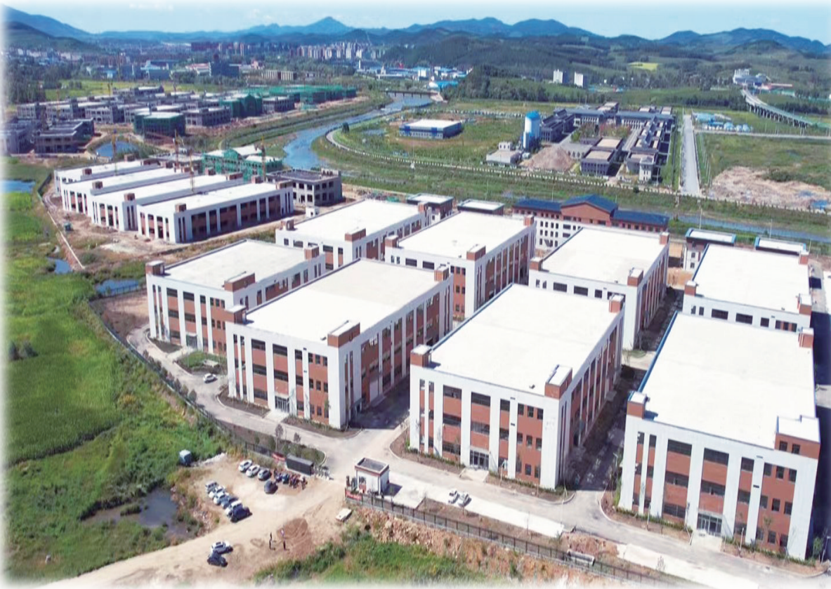
柳河县大健康产业园区基础设施(标准厂房)建设项目进展顺利。
