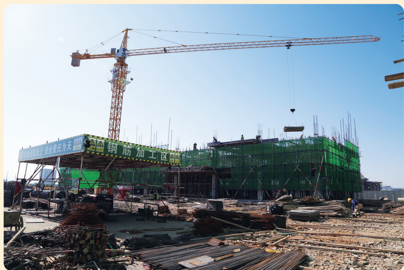
日前,在位于珲春边合区的珲春海洋经济功能食品产业园项目施工现场,300余名工人正抢抓晴好天气加快推进项目建设。该项目总建筑面积约6.24万平方米,总投资约3.27亿元,主要建设综合楼、宿舍、冷库、厂房等,以及其他附属设施。项目于今年6月开工,预计2023年8月竣工投用。目前,该项目已完成总工程量的70%。
