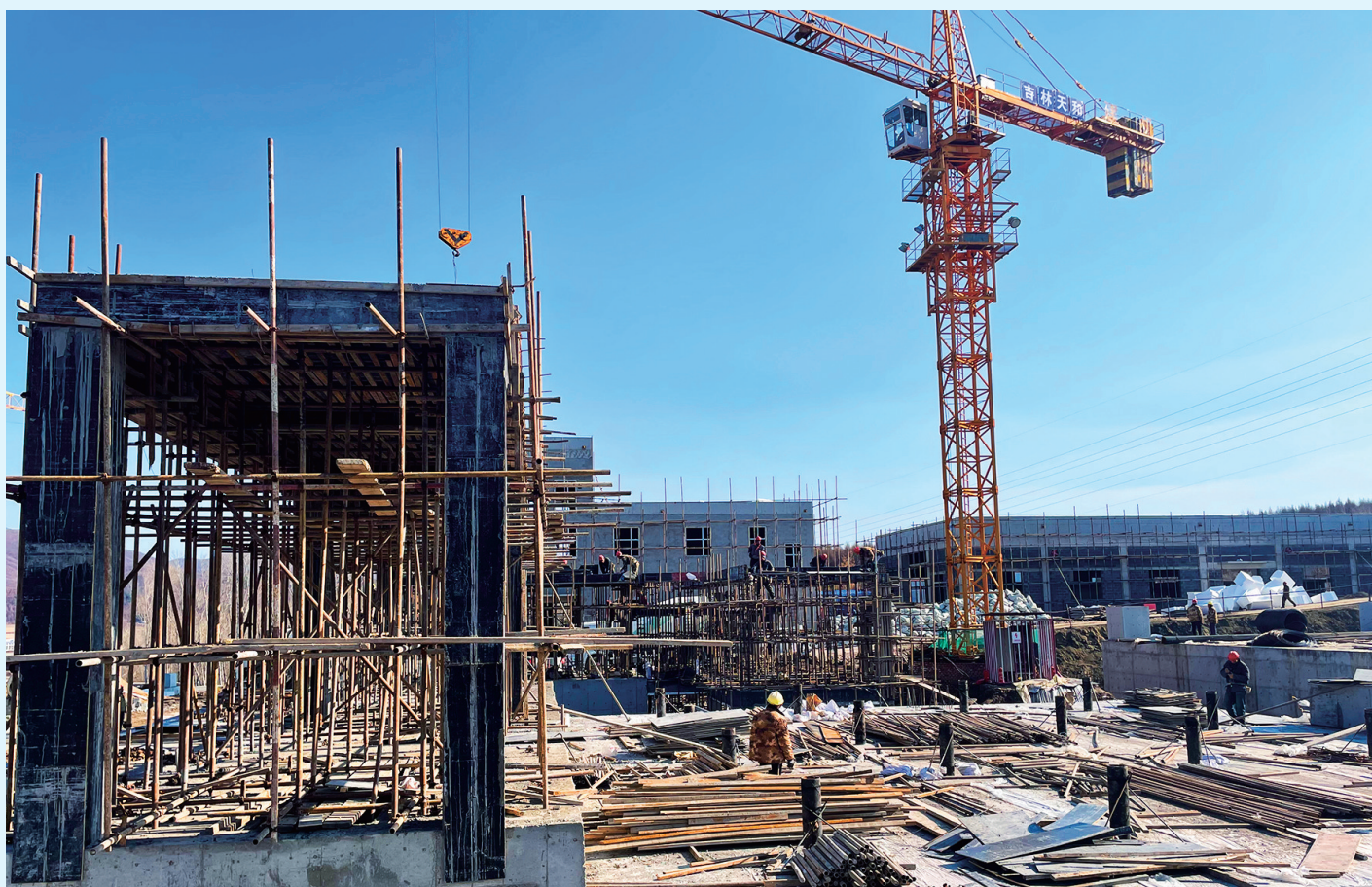
为解决供水能力问题,汪清县实施了总投资1.56亿元的节水型城市建设项目福泉净水厂改扩建工程。原有净水厂日处理规模为3万立方米,扩建后增加至3.5万立方米;新建水厂日处理规模将达5万立方米。目前,该项目已完成投资8790万元,老水厂改建已基本完工,新水厂主体工程已完工,正在进行室内工程施工和设备安装。 王雨 摄
