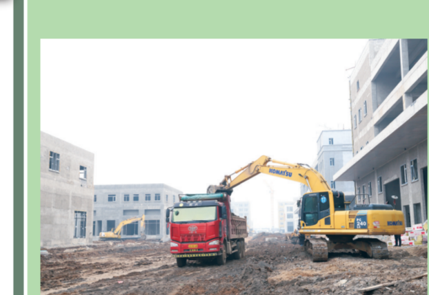
农产品冷链物流园正在进行外网铺设、路面平整和窗户安装。
