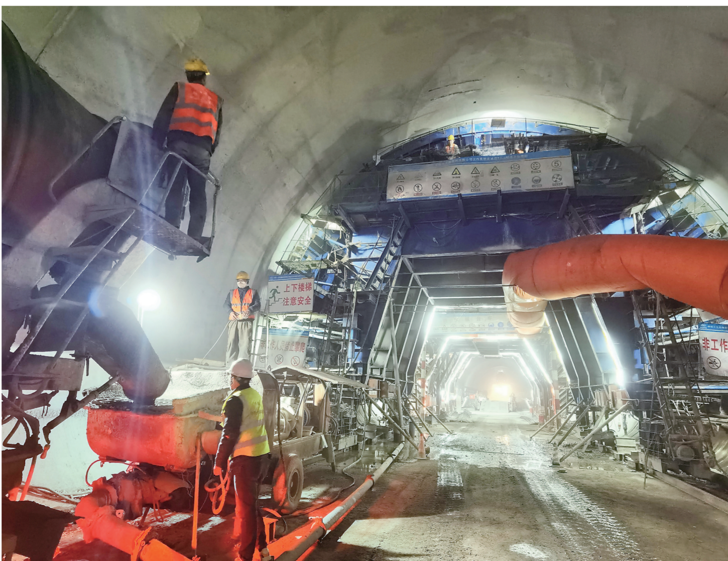
11月17日,在中铁十五局集团110名工人的昼夜奋战下,全长2531.6米的沈白高铁东沟隧道已掘进422米,施工进展顺利。图为隧道二衬施工现场。本报记者 隋二龙 摄
