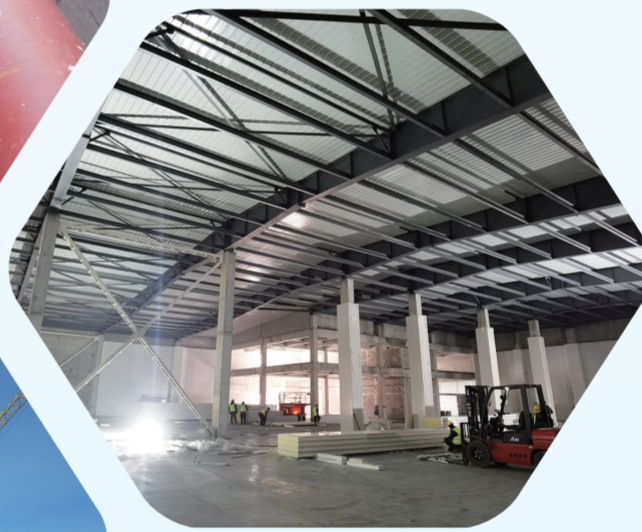
↓正在进行内部装修的通化人参电子商务产业园冷库。
