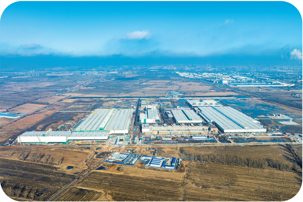
奥迪一汽新能源汽车项目完成暖封闭。
