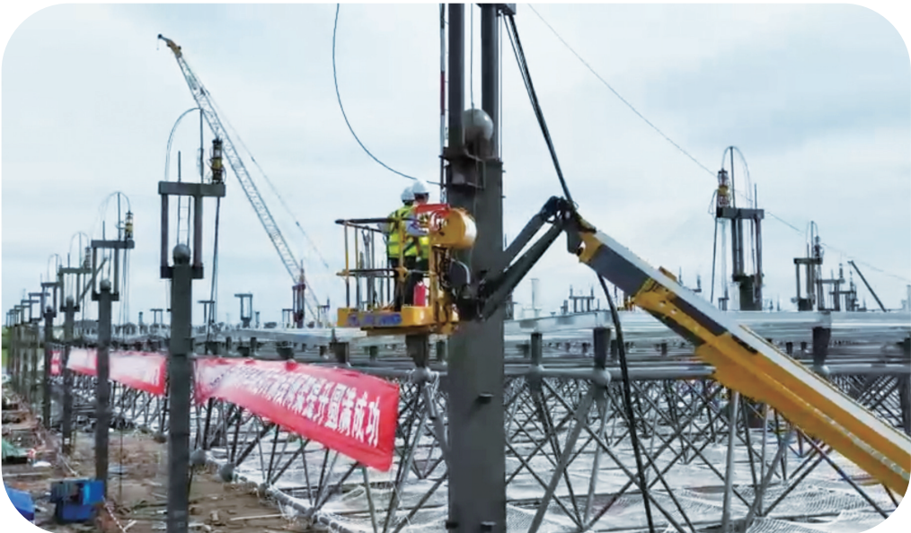
工人们正在进行施工。
