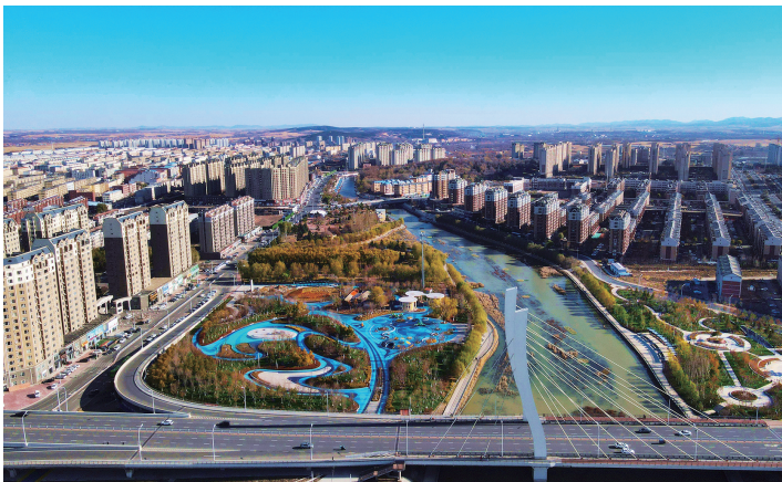
小南河综合治理项目即将完工。
