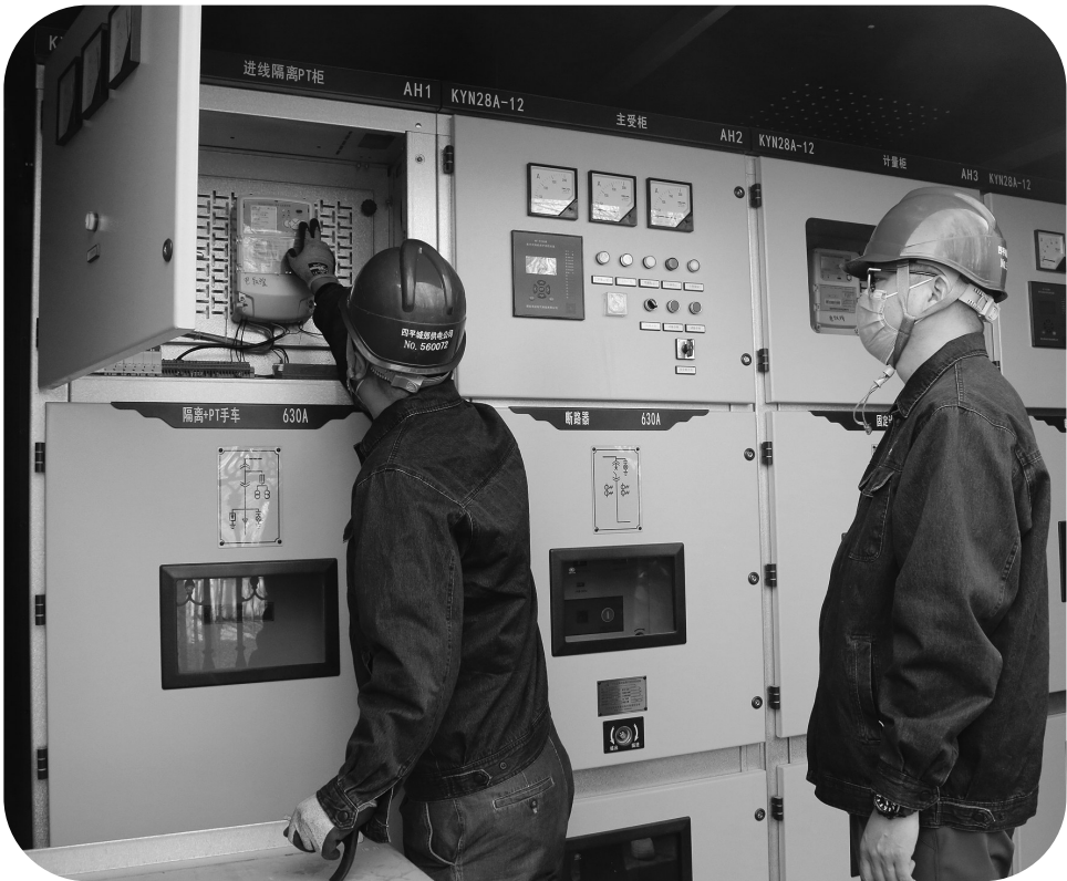
国网四平供电公司员工为四平市宏熙城乡建设投资有限公司检查电取暖用电安全。
