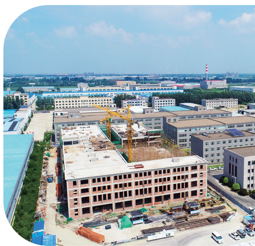
研奥电气续建项目拔地而起。(资料图片)
