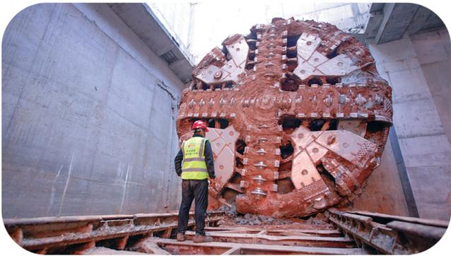
长春轨道交通7号线西四环站至兴安路站盾构区间贯通。图为盾构机出洞现场。李天玉 摄
