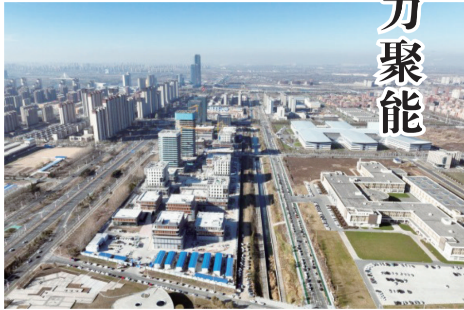
正在施工的长春智能光谷产业园。
