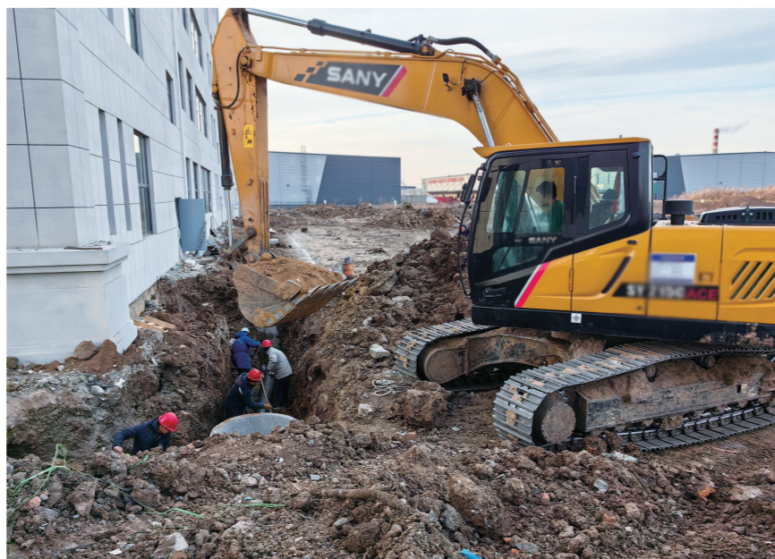
吉林省源泉智能装备制造产业园现场施工现场。
