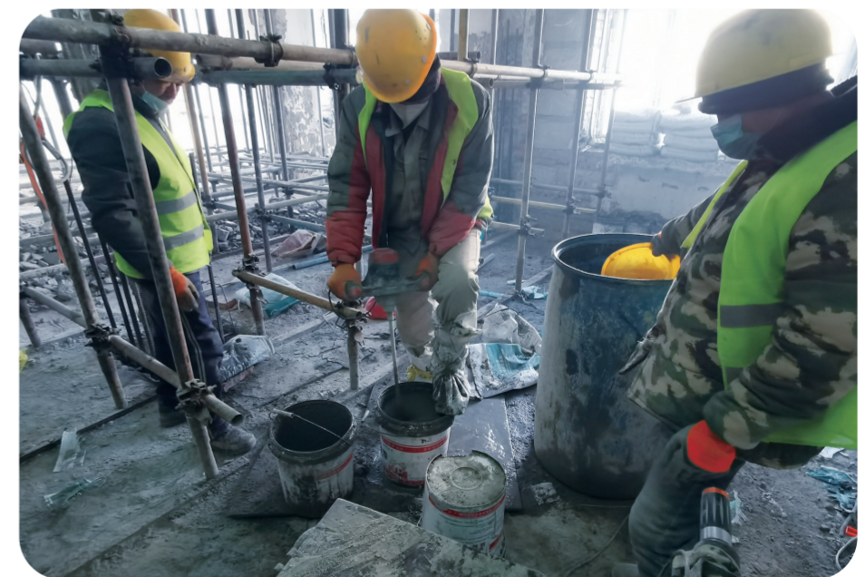
朝阳区公共卫生服务体系建设项目施工现场。
