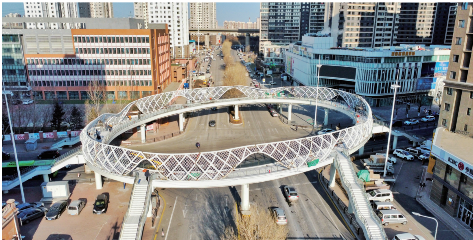
近日,长春市首座环形天桥—永宁路东北街人行天桥进入工程收尾阶段。天桥主体结构包括一座主桥和八座梯道,建成后将改善周边交通情况,实现人车分流,提升安全水平。 本报记者 张野 摄
