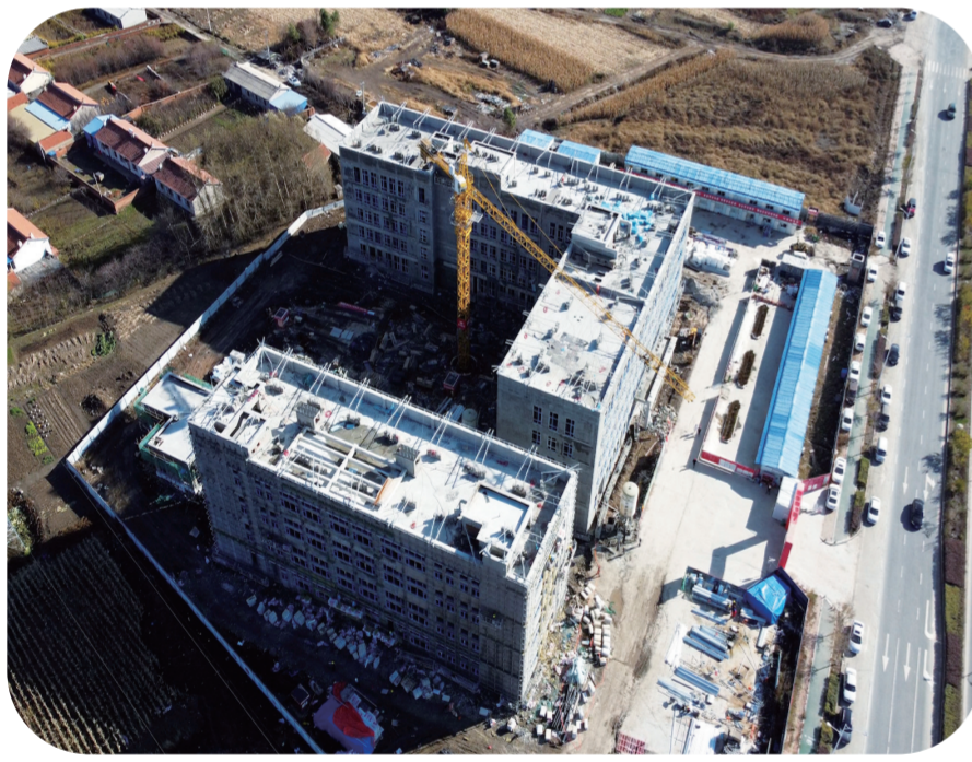
二道区疾控体系建设项目施工现场。
