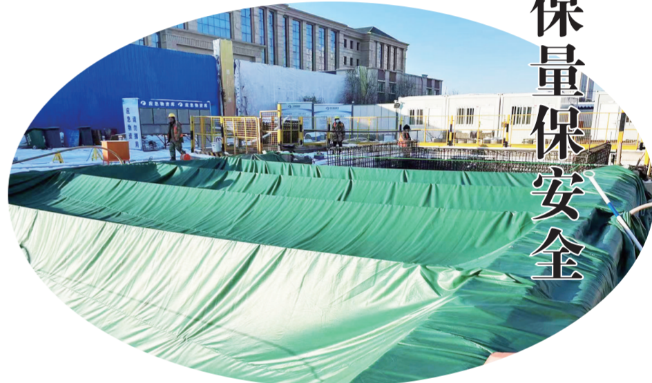
长春轨道交通项目冬季施工不停歇。
