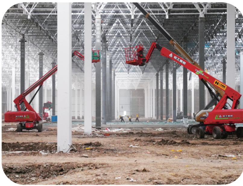
奥迪一汽新能源汽车项目施工现场。
