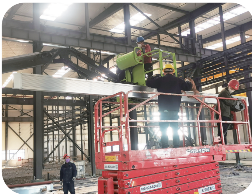
楚天华通医药装备智能制造产业园项目施工现场。
