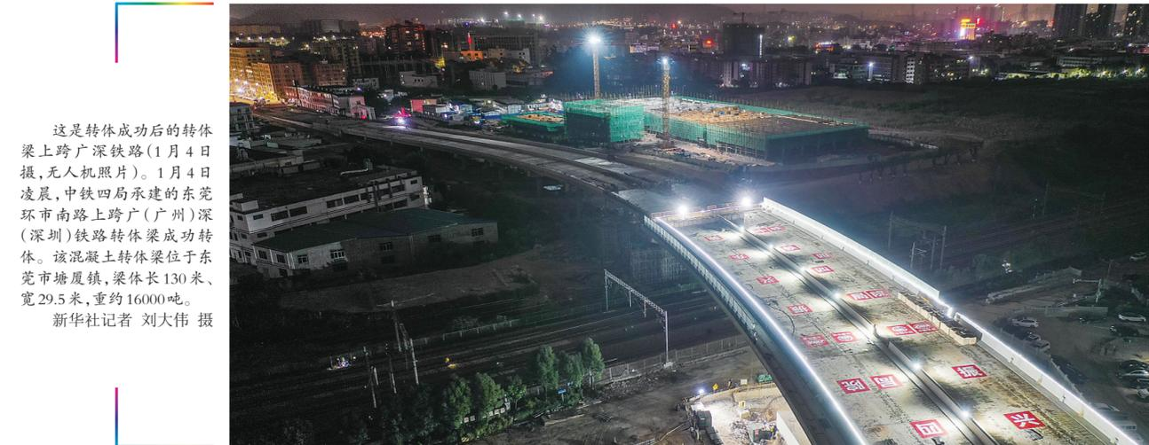
这是转体成功后的转体梁上跨广深铁路(1月4日摄，无人机照片)。1月4日凌晨，中铁四局承建的东莞环市南路上跨广(广州)深(深圳)铁路转体梁成功转体。该混凝土转体梁位于东莞塘厦镇，梁体长130米、宽29.5米，重约16000吨。
