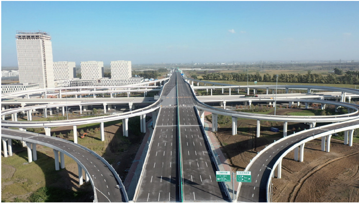
长春新区“三路七桥”工程。
