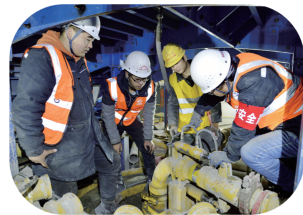
←寒冬腊月,在沈白高铁吉林段TJ-6标施工现场,中铁二十三局集团的建设者们攻坚克难,全力施工,确保项目如期竣工。杨景霜 车宝华 摄
