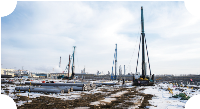
吉林石化转型升级项目建设施工现场。王英刚 摄
