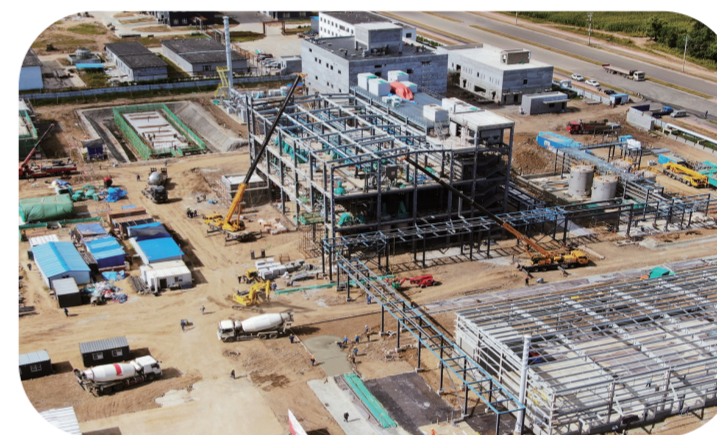
艾仕德汽车涂料项目现场。
