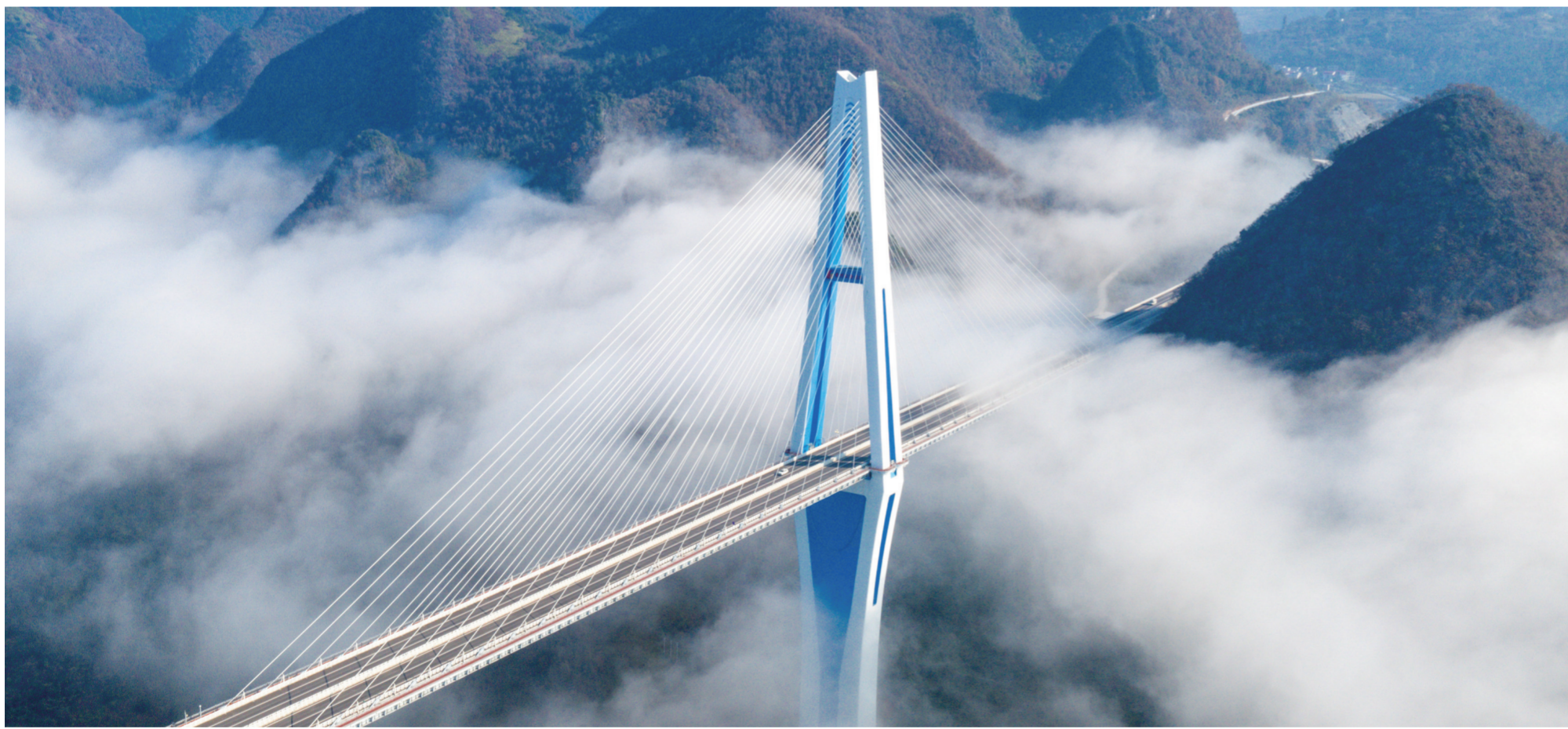
图为贵州平塘特大桥(无人机照片)。从卫星的视角向下俯瞰,高桥宛如纽带,跨越深邃的峡谷、沟壑,将纵横的群山紧密相连。从穿越机视角向前“飞越”,我们仿佛以飞鸟的视角穿越贵州的百万大山,与山海相连。新华社记者 欧东衢 摄
