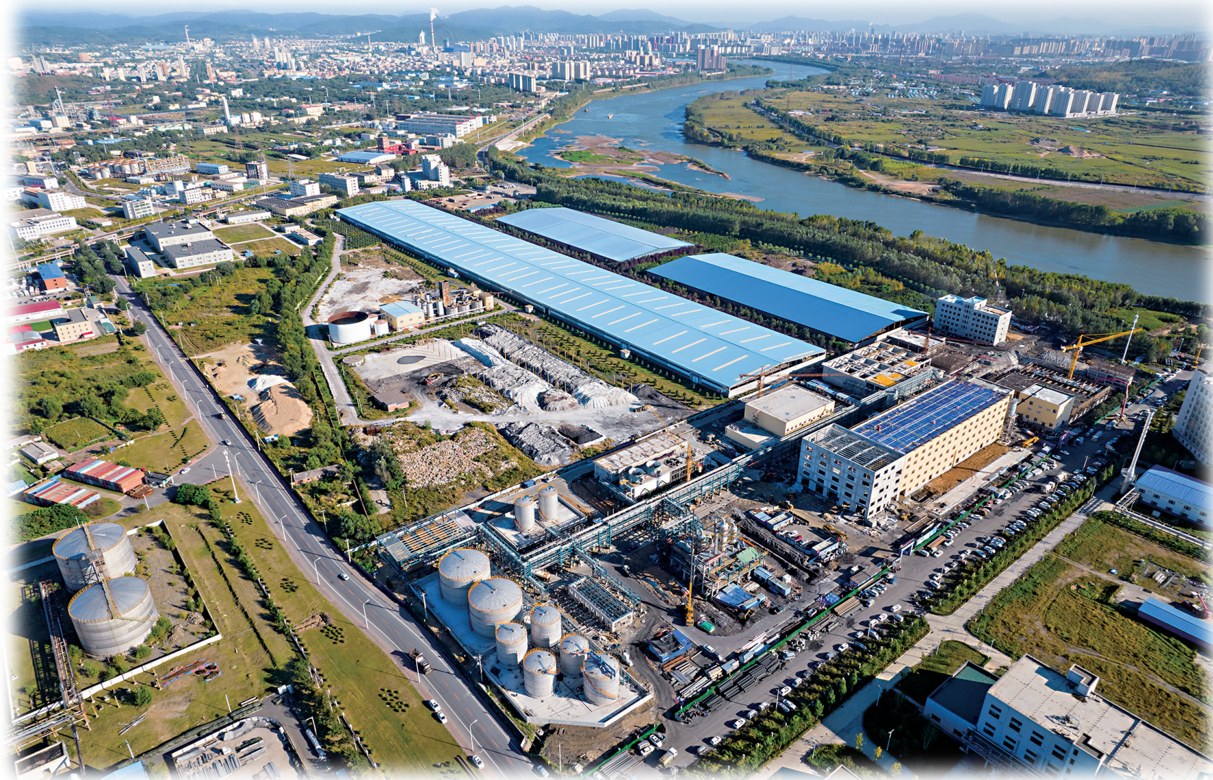
吉林转型升级工业污水配套项目——丙烯精处理装置构筑物主体结构完成。
