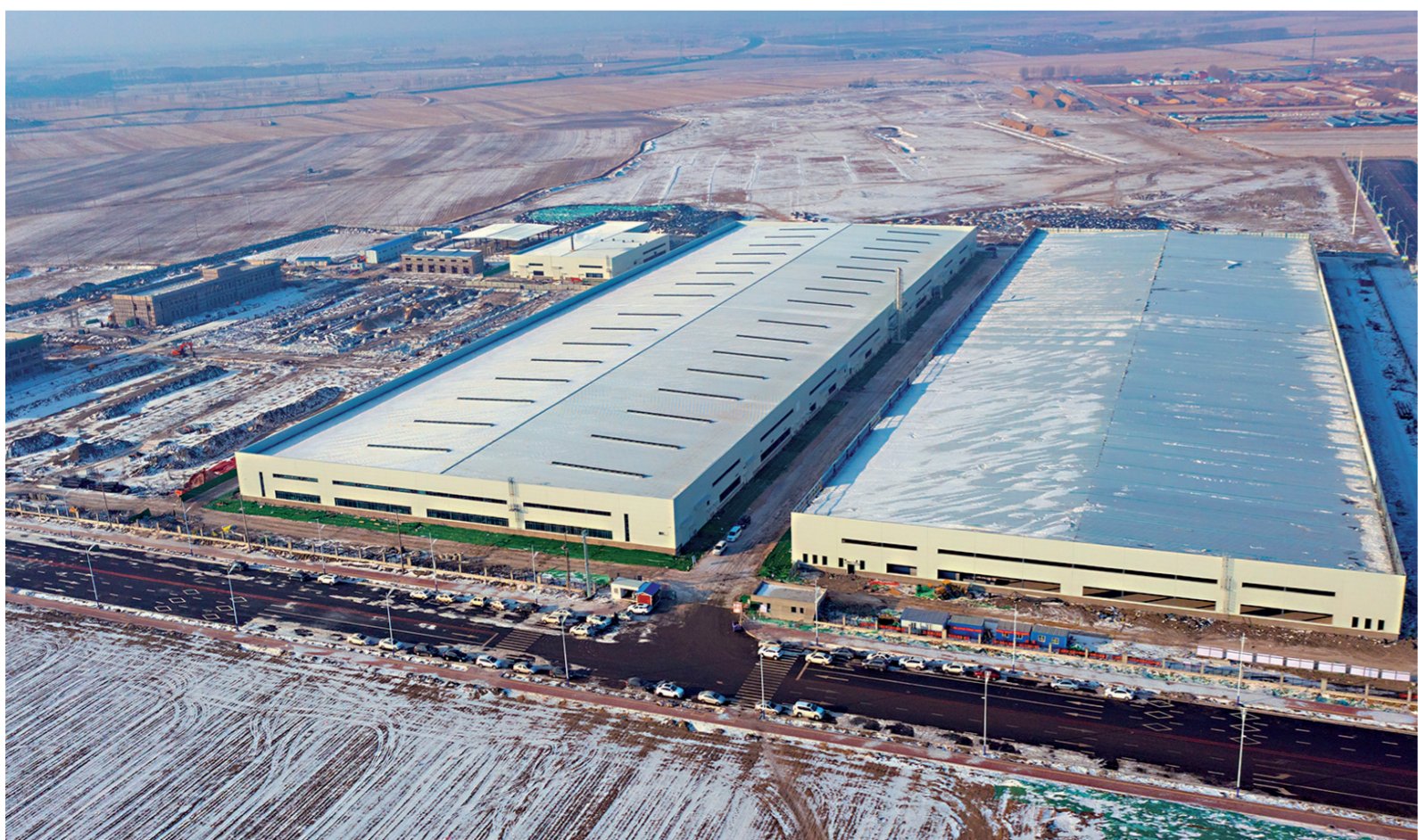
大力开展招商引资,加快项目建设步伐,这是松原正泰新能源产业基地。
