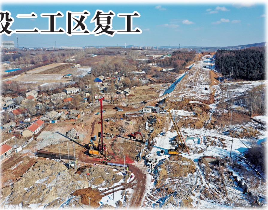
长春东南湖大路项目一标段二工区施工现场。
