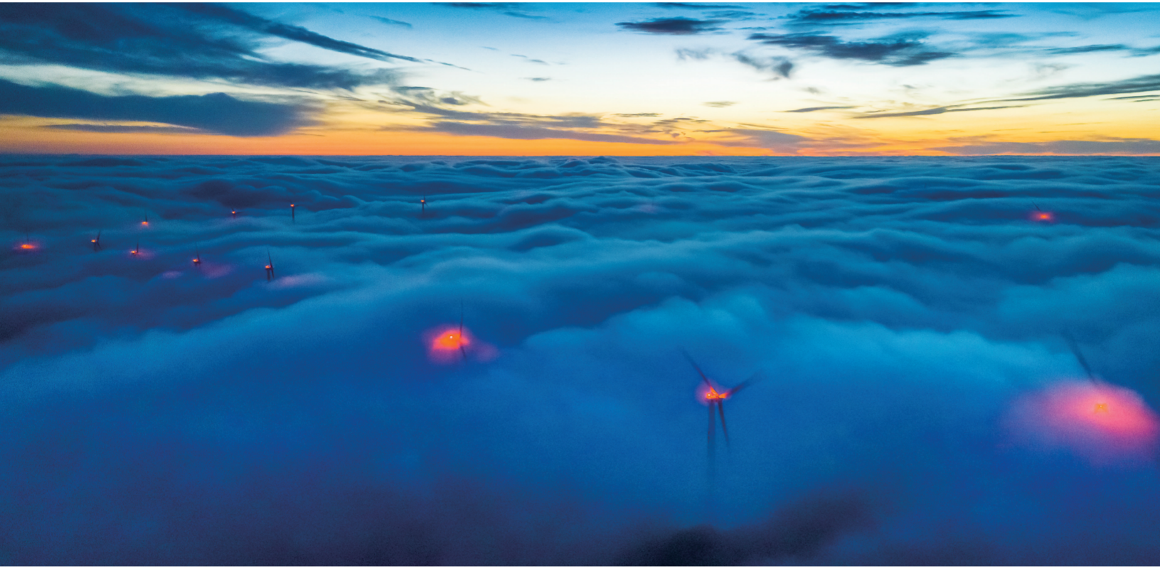
2月23日晚在湖北省宜昌市秭归县两河口镇云台荒村拍摄的风力发电机组(无人机照片)。
