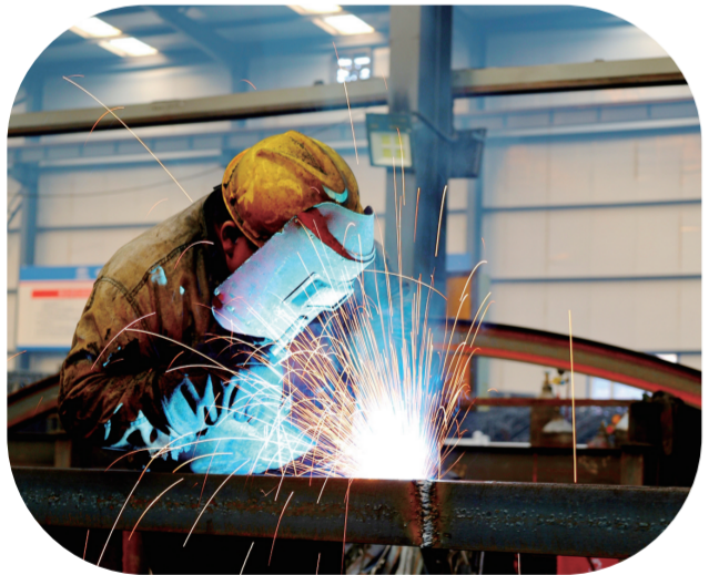
产业发展，交通先行。沈白高铁吉林段TJ-6标全长30.191公里，隧道占比高达82.3%。中铁二十三局集团项目部集中力量，全力以赴保进度。图为建设者正在加工隧道钢拱架。 杨景霜 摄
