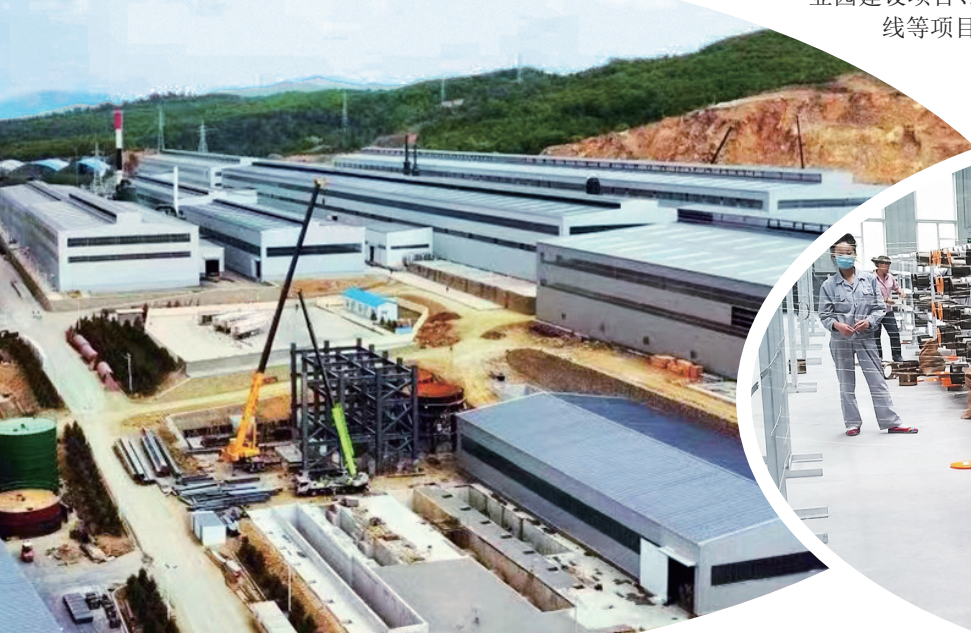
中溢集团(吉林)新能源科技有限公司年产30万吨新能源负极材料项目建设现场。程速元 摄
