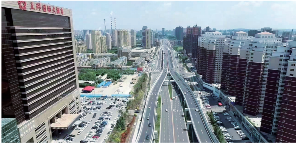
吉林大路快速路提升改造工程。
