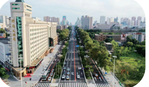
人民大街精品街路工程。
