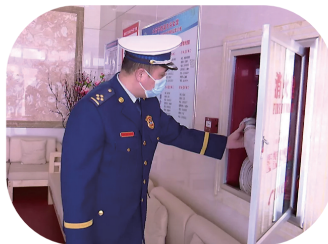
近日，大安消防救援大队对辖区消防产品销售、使用领域开展消防产品质量专项检查专项行动，严厉打击生产、销售、使用假冒伪劣及不合格消防产品的违法行为。（董辉 摄）
