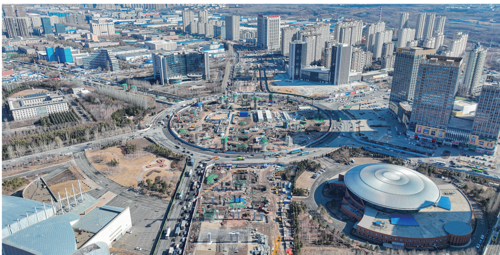
连日来,长春市世纪大街快速路项目正紧锣密鼓向前推进。据了解,该项目包括世纪广场互通立交及6条道路,全长12.4公里。建成后,将实现东部快速路、南部快速路与四环路快速转换,增加净月区与主城区快速连接通道,改善世纪广场交通拥堵现状。 本报记者 张野 摄
