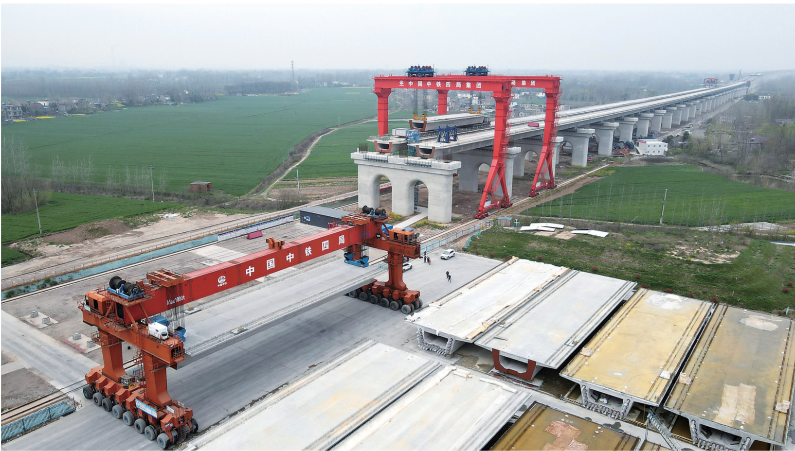
这是3月29日拍摄的中铁四局巢马城际铁路箱梁架梁现场(无人机照片)。
