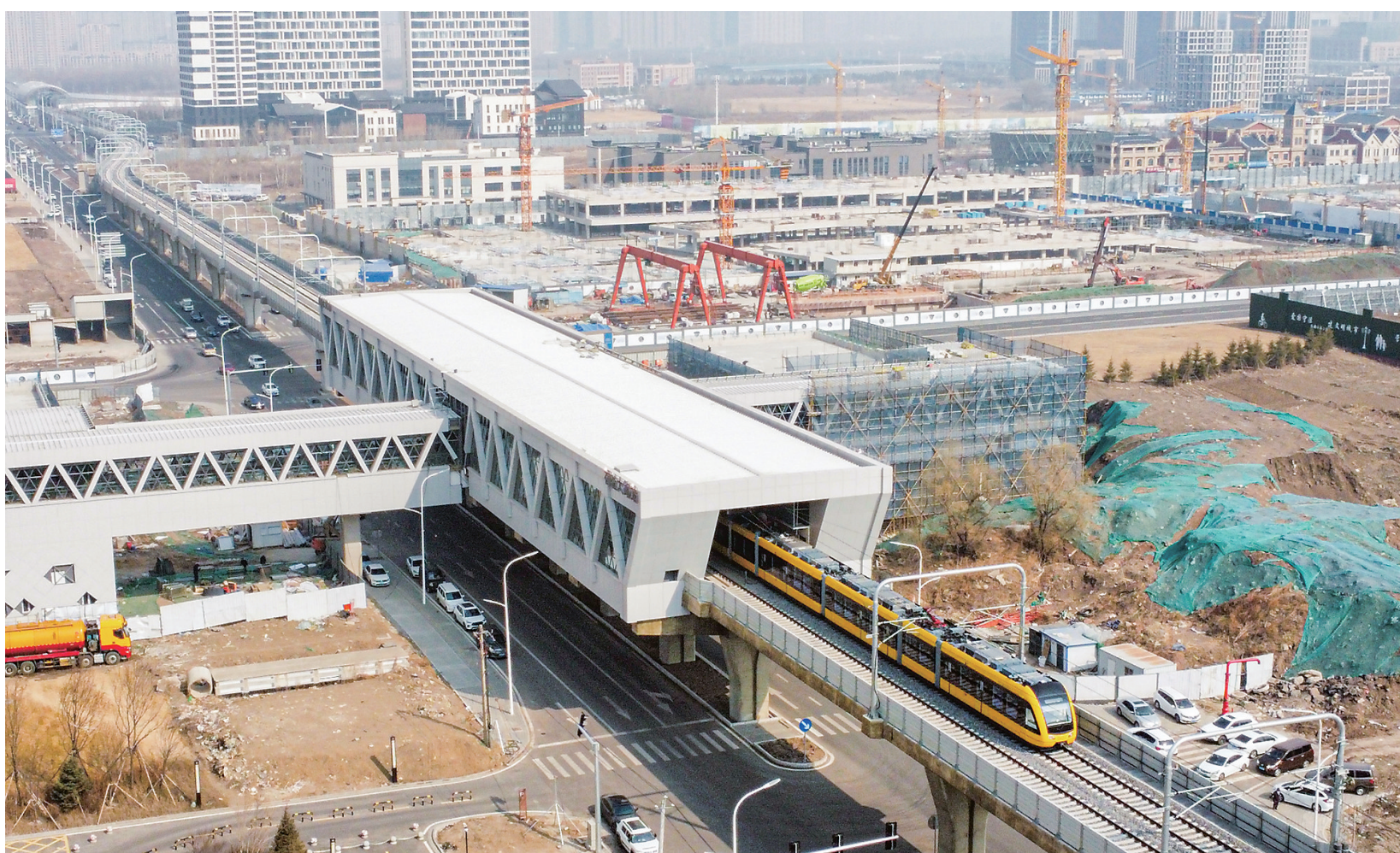
近日,长春轨道交通4号线南延线正式启动“跑图”试运行工作,运营筹备进入全面冲刺阶段。目前,4号线南延工程5座车站的主体结构已经全部完成,正在进行装修。 本报记者 张野 摄
