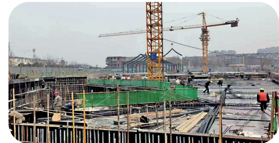
中车历史街区项目施工现场正在火热抢工期。
