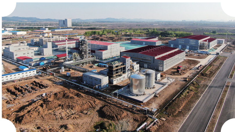
中泽控股集团钼深加工项目现场。
