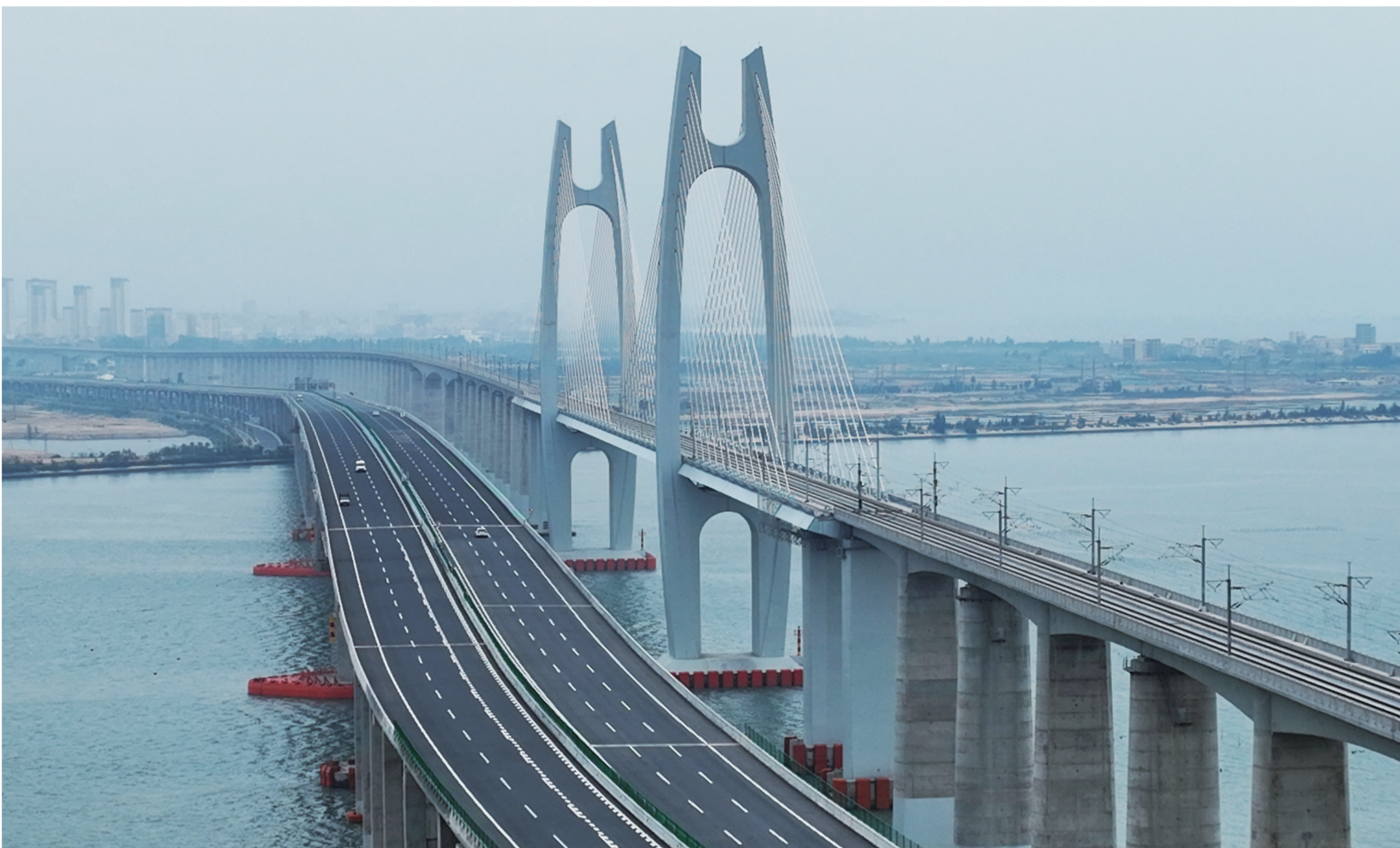
4月12日拍摄的新建福厦铁路安海湾跨海大桥(右)(无人机照片)。
