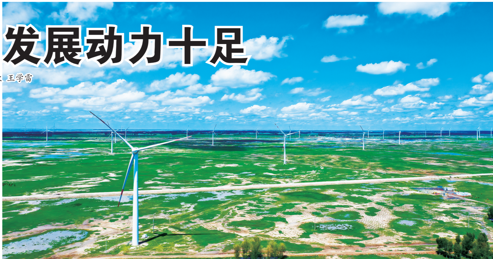
松原市按照省委、省政府部署要求，全面落实“一主六双”高质量发展战略，全力推进“陆上风光三峡”工程建设和“氢动吉林”行动实施，积极打造国家级清洁能源生产基地。
