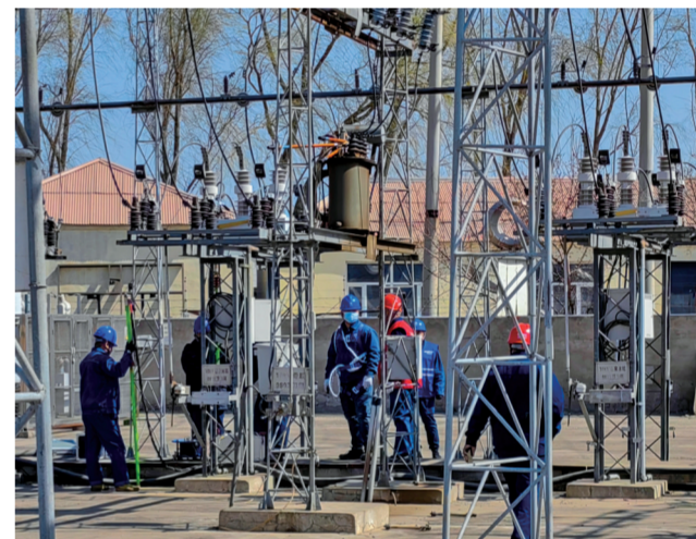
国网吉林省电力有限公司松原市城郊供电公司积极组织工作人员对春耕春灌供电线路、设备进行全面检修，全力保障春耕备耕用电。
