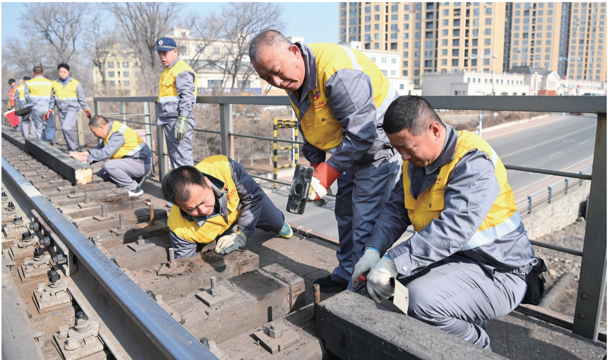
吉林通化工务段桥隧车间第一维修小组的工作人员正在维修、养护路轨。 本报记者 赵博摄
