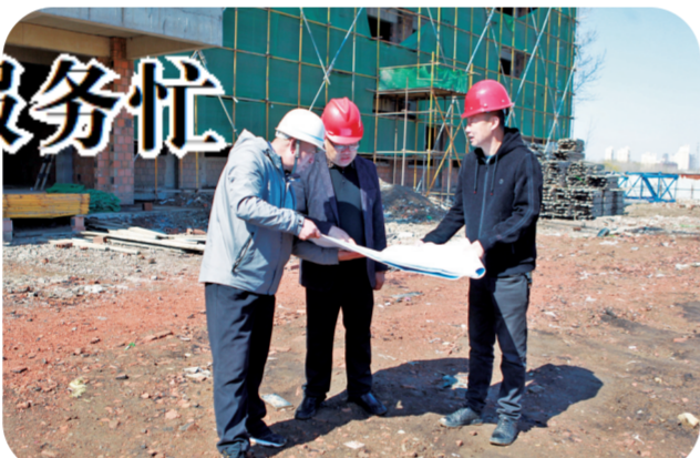
崔双伟(左二)与建设单位研究项目施工方案。赵蓓蓓 摄
