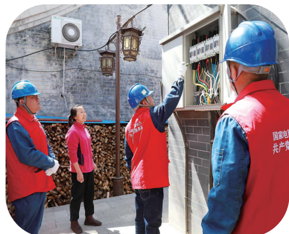
为确保辖区电力安全可靠供应,日前,国网前俄罗斯县供电公司查干湖供电所员工到用户家开展用电隐患排查工作。 吉翔泽 摄
