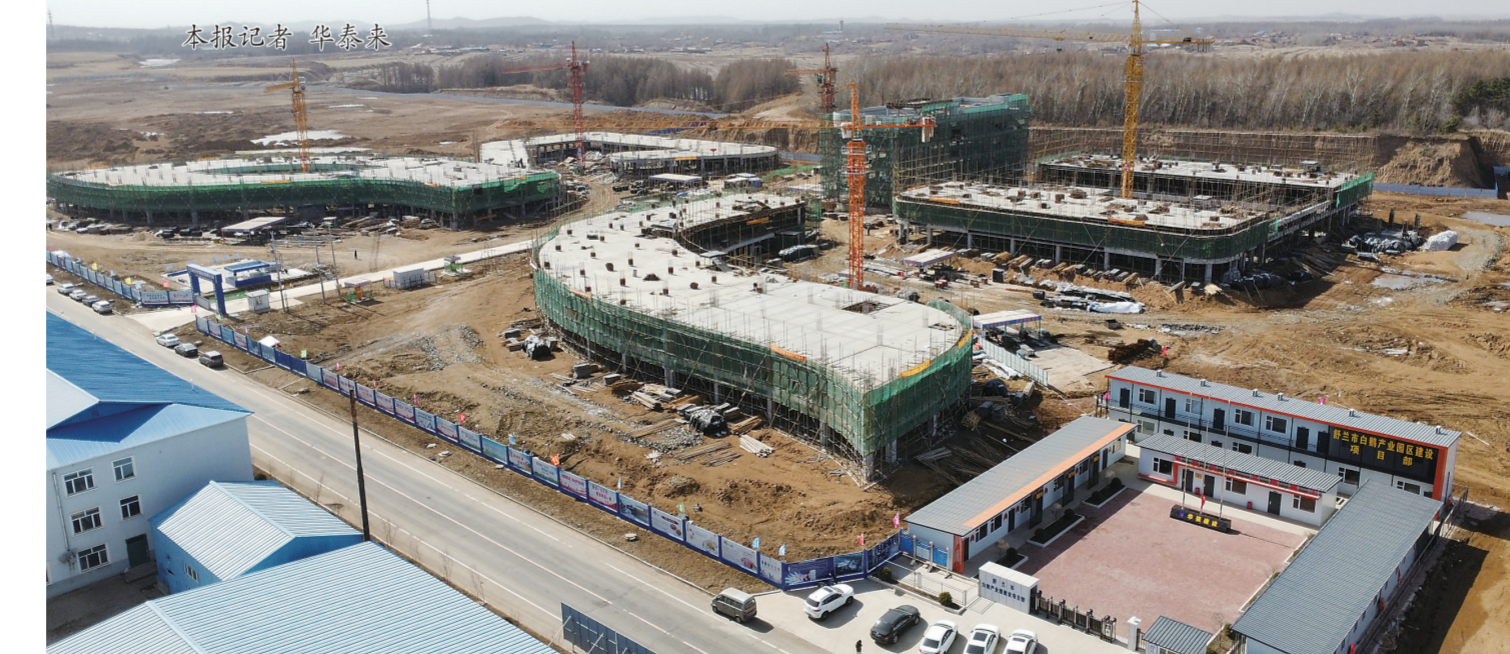
近年来,舒兰市大力发展白鹅产业,投资建设了集鹅肉加工、羽绒制造、产品研发于一体的白鹅产业园。据了解,该项目计划投资14.2亿元,建成后将有力助推舒兰市白鹅全产业链发展,并提供大量就业岗位。图为该项目核心区建设现场。
